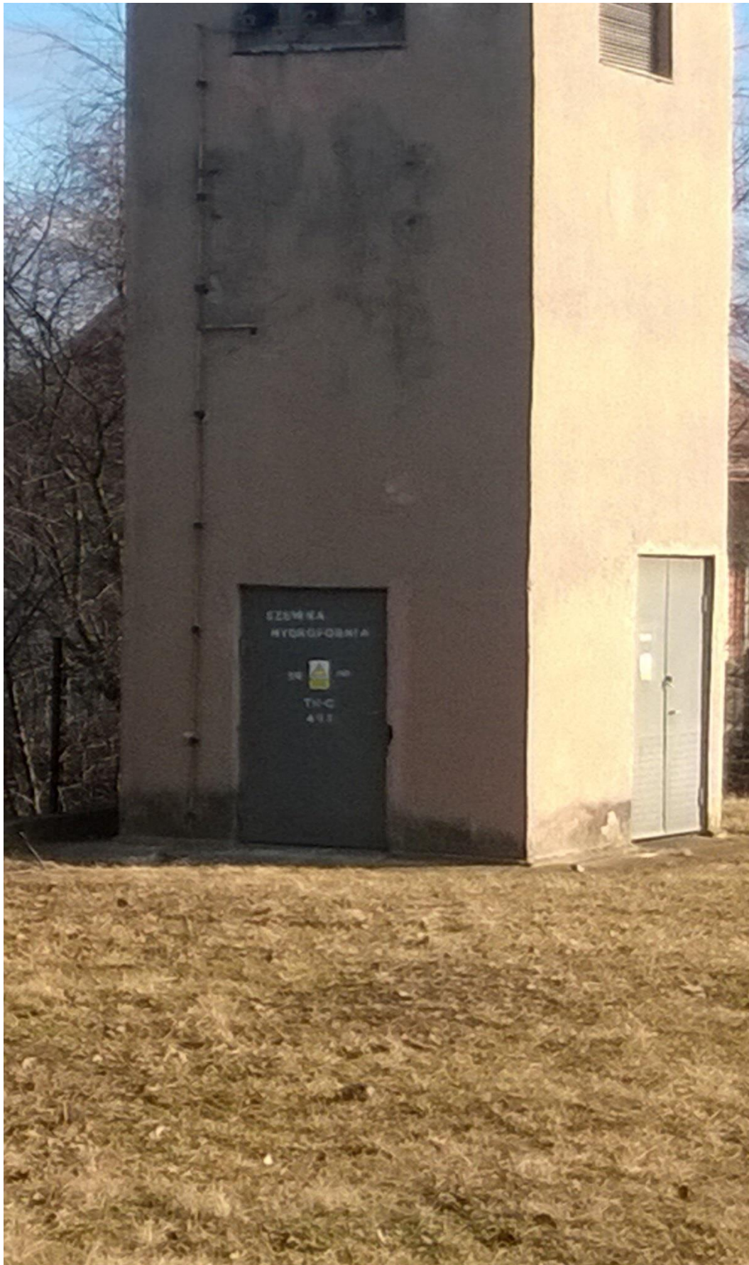
Przykład stacji transformatorowej budynkowej (Szewna hydrofornia)
